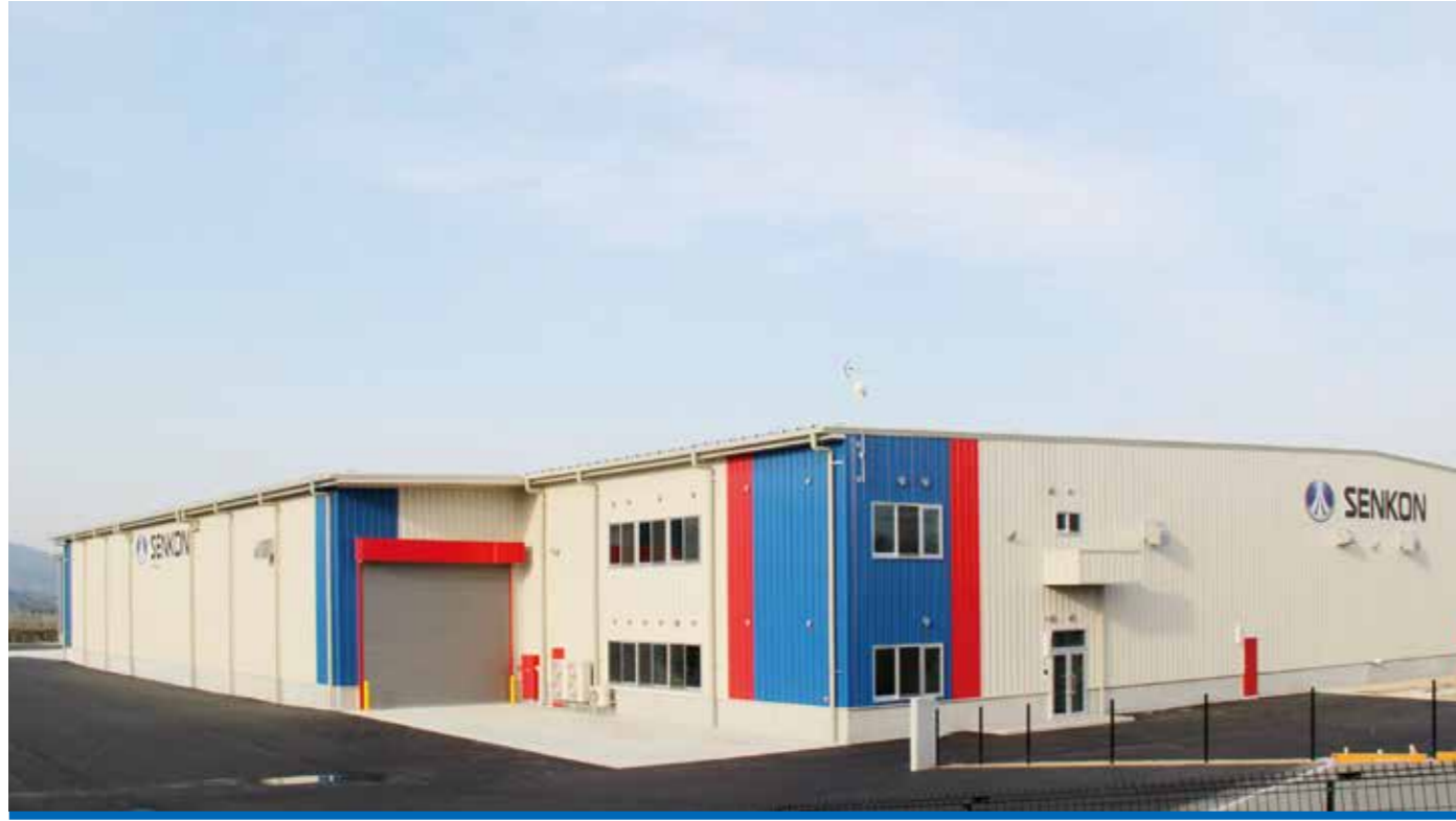
センコン物流東根第二物流センター新築工事 (山形県東根市/2017年)
