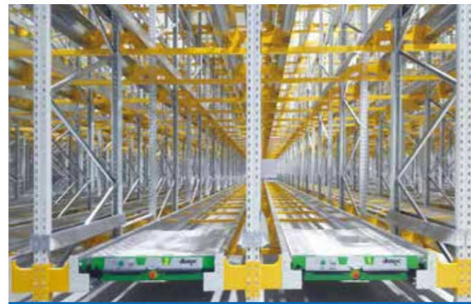
物流倉庫パレットラック設置工事 (宮城県名取市/2018年)
