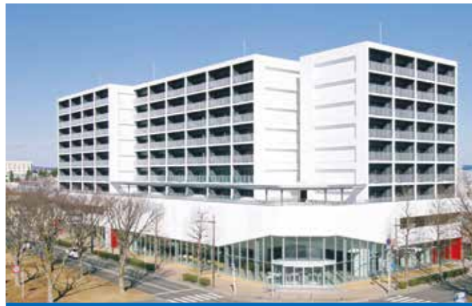
仙台卸町コミュニティセンター新築設備工事 (宮城県仙台市/2016年)
