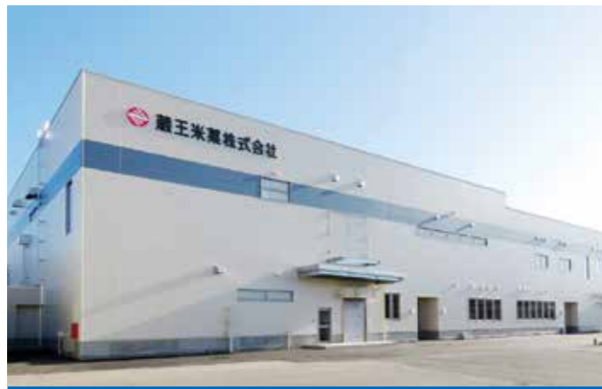
蔵王米業株式会社工場新築設備工事 (山形県村山市/2019年)
