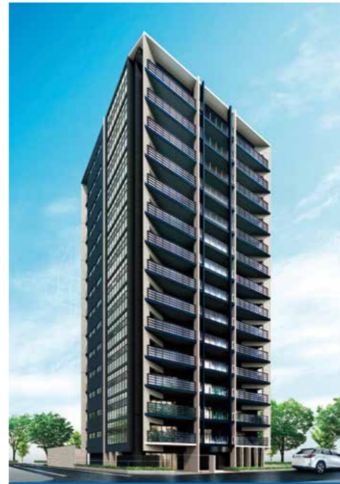
レーベン仙台一番町新築機械設備工事 (宮城県仙台市/2019年)
